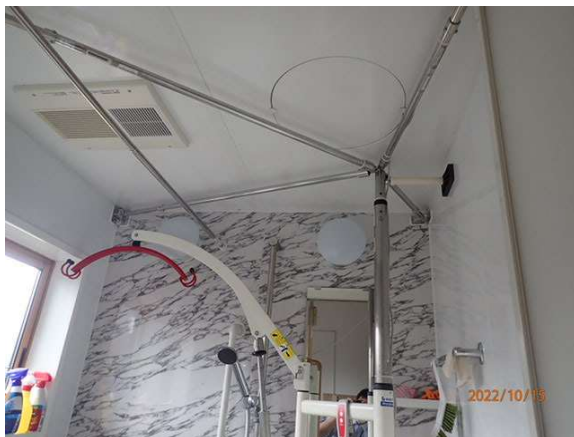
天井は各壁面に突っ張りを付けて設置
